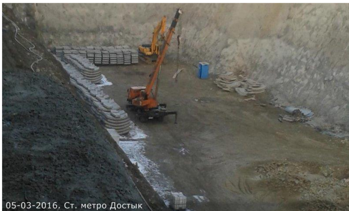
Рисунок 4-строительная площадка станции «Достык»
